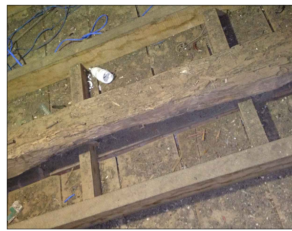
FLEXÃO E DETERIORAÇÃO DE PEÇAS DE APOIO DAS TESOURAS, DEVIDO À EXPOSIÇÃO POR UMIDADE, DECORENTE DE VAZAMENTOS DE ÁGUA DA CHUVA
