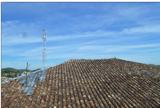
DESNÍVEL DE CUMEIRA E UTILIZAÇÃO DE MANTAS CONTRA OS VAZAMENTOS
