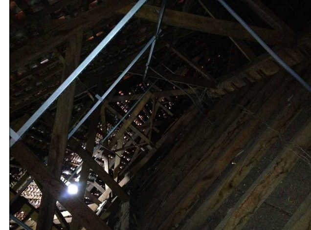
DESLOCAMENTO DE TELHAS, BURACOS E FISSURAS NAS TELHAS, O QUE OCASIONAM OS VAZAMENTOS.
