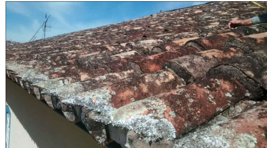
ACUMULO DE CROSTA NEGRA, LIMO E INICIO DE PEQUENAS VEGETAÇÕES NO TELHADO.
