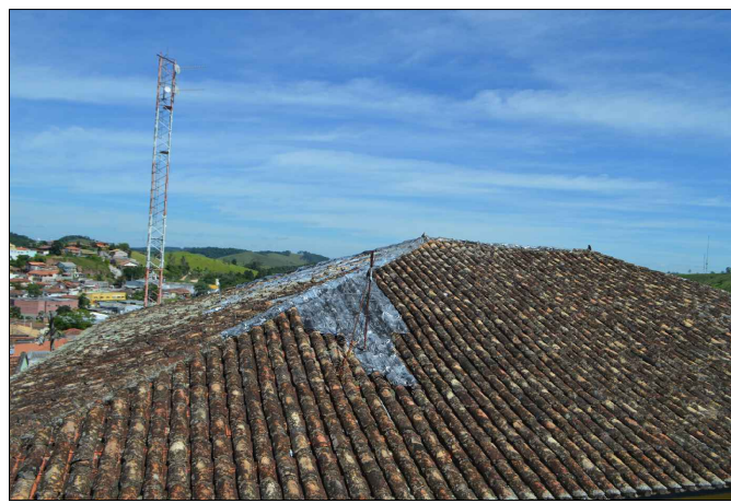
DESNÍVEL DE CUMEIRA E UTILIZAÇÃO DE MANTAS CONTRA OS VAZAMENTOS
