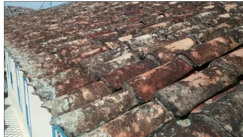
FIXAÇÃO DE TELHAS COM ARGAMASSA, FISSURAS E DIFERENÇA DE TONALIDADE DAS TELHAS
