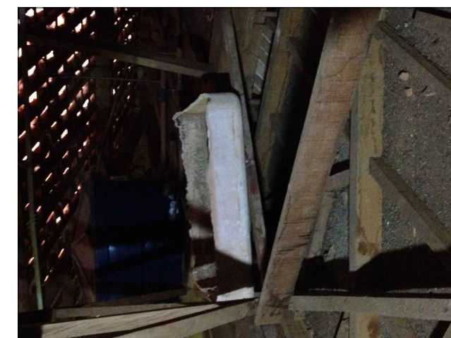
DISTRIBUIÇÃO INADEQUADA DA FIAÇÃO E RESTOS DE SUCATA, PROVENIENTE DE UMA ANTIGA CAIXA D'ÁGUA DE FIBROCIMENTO
