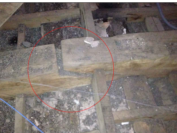
FLEXÃO E ROMPIMENTO DE EMENDA DA VIGA DE APOIO DA TESOURA CENTRAL
