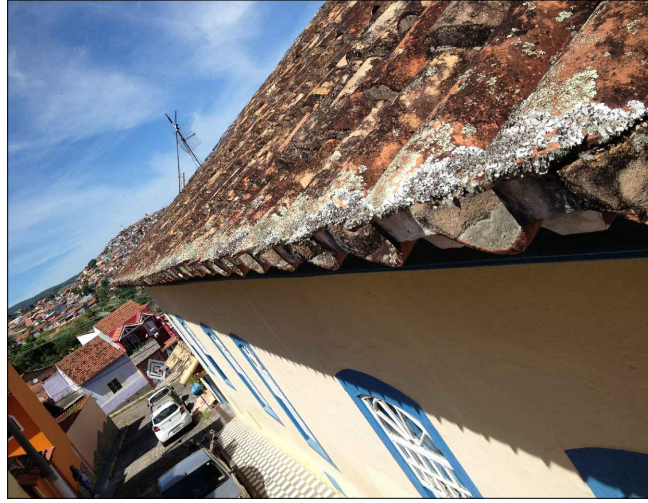
ACUMULO DE CROSTA NEGRA, LIMO E INICIO DE PEQUENAS VEGETAÇÕES NO TELHADO.
